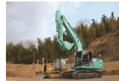
ICT建設機械
